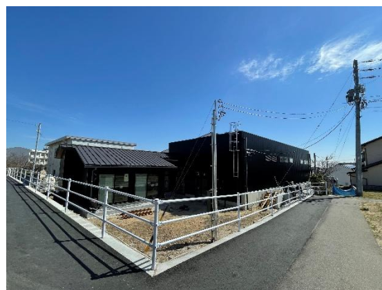
【建物完成(令和8年3月)】
