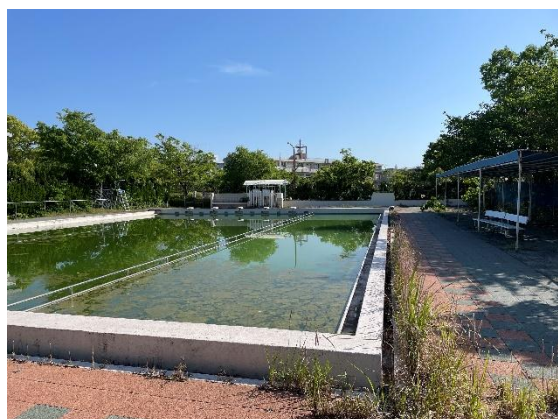
【プール解体前(令和6年7月)】
