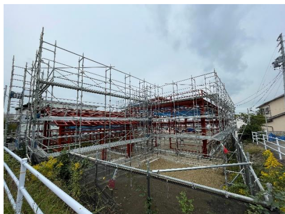
【建物骨組み(令和7年10月)】
