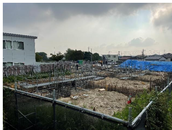
【基礎工事(令和7年9月)】
