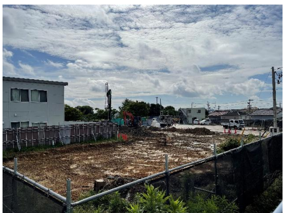
【埋設配管工事(令和7年6月)】
